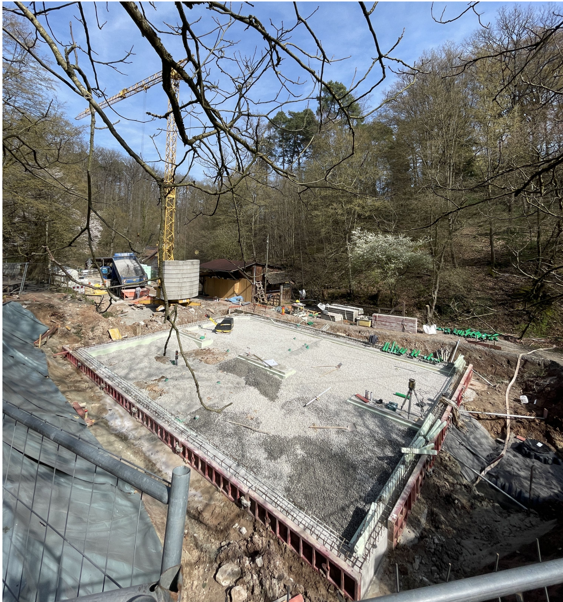
Die Bodenplatte wird vorbereitet
