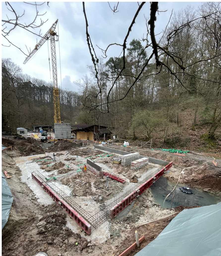
Die Bodenplatte wird vorbereitet
