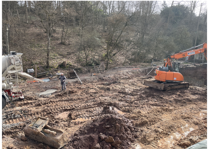
6. März Erste Punktfundamente werden gegossen
