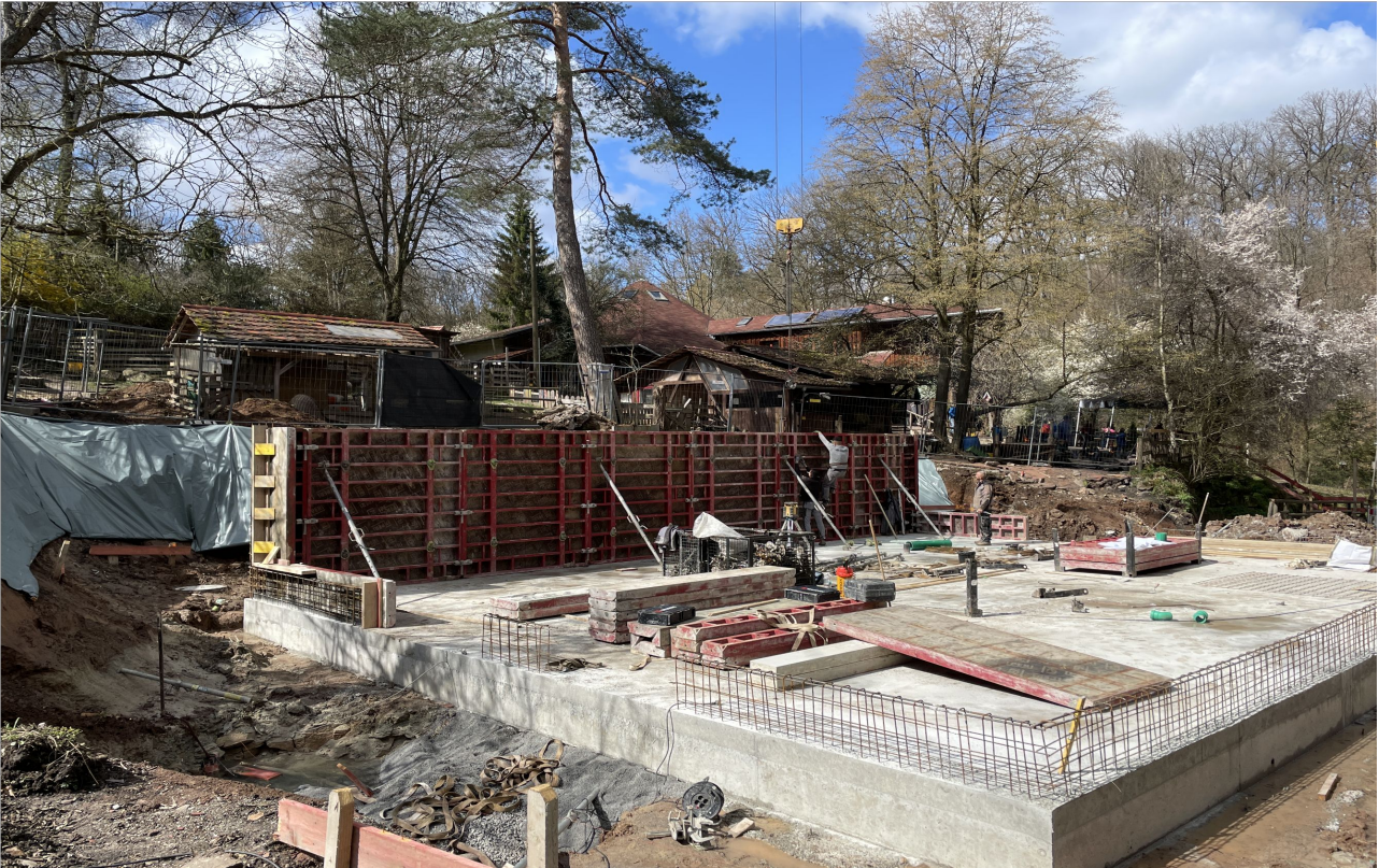
1. April Die Bodenplatte ist gegossen, die Wand nach Westen ist verschalt – der Rohbau ist fast fertig!
