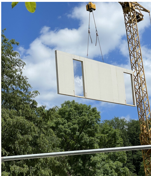
Schwebende Wände und schon am ersten Abend steht das Untergeschoss
